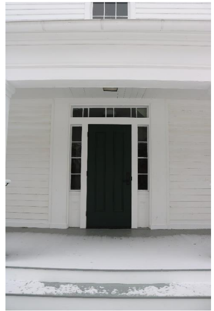
New back porch door
